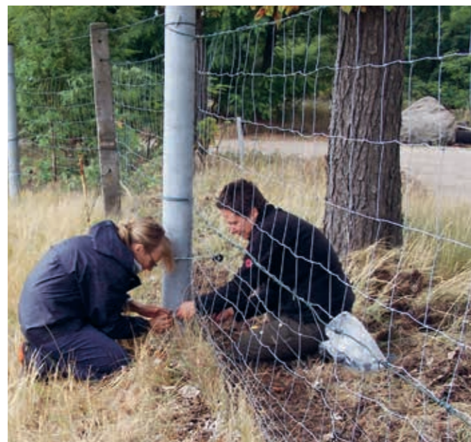
Obr. 1 Dobrovoľníci dopĺňajú na plote ochranu, aby sa šelmy nemohli podať podhrabať. (Fotografia: S. Dittgen)
